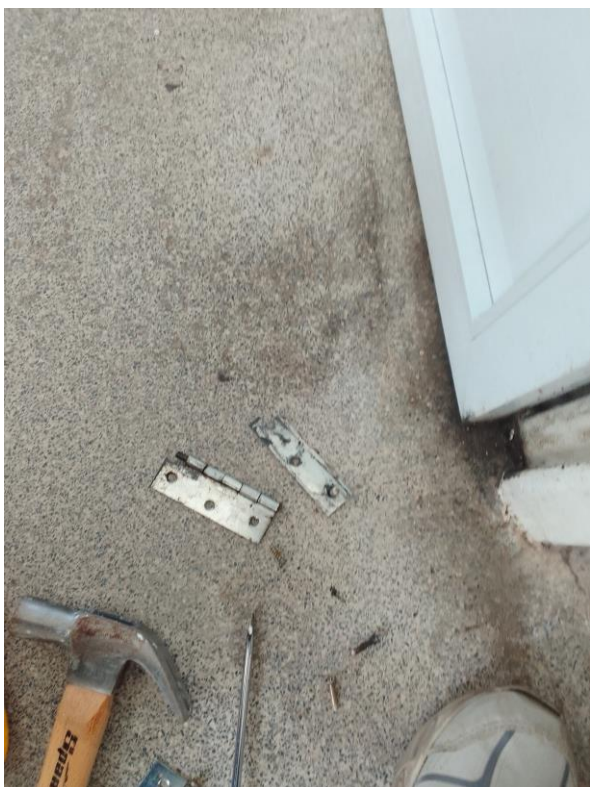
03/11 – substituição dobradiça quebrada entrada recepção pediatria
