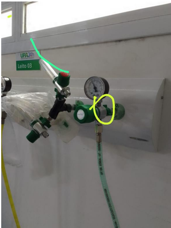
03/11 - trocado borracha de vedação leito 3
