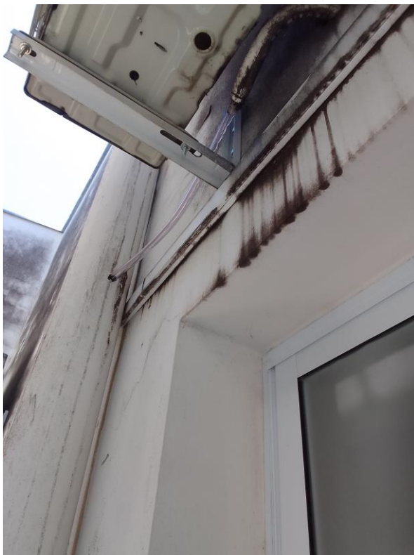
6/11 – instalação mangueira consultório 7
