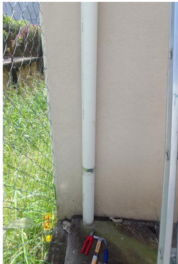
08/11 – conserto tubulação escoamento de água da chuva vandalizado
