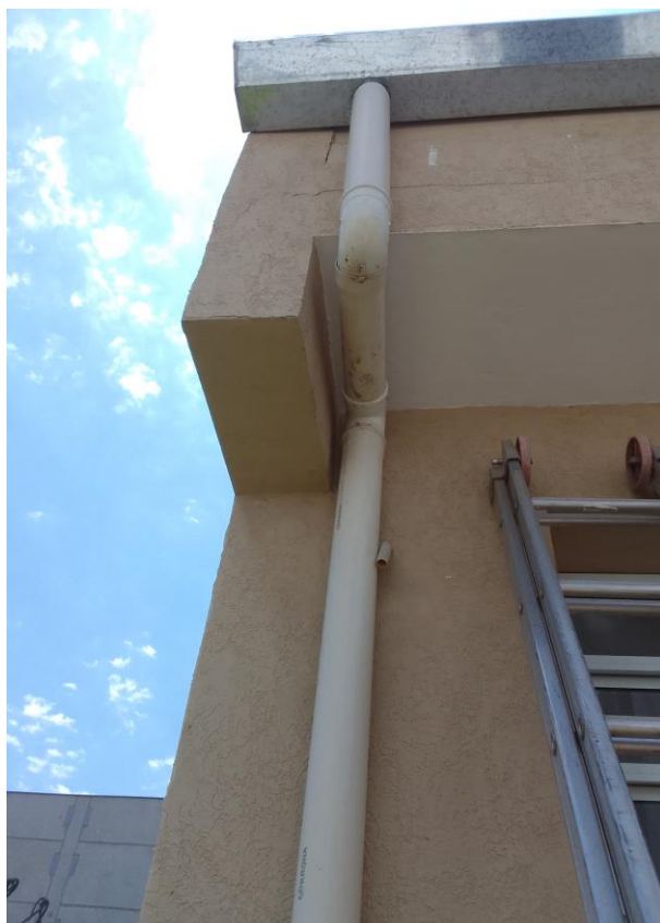
08/11 – conserto tubulação escoamento de água da chuva vandalizado
