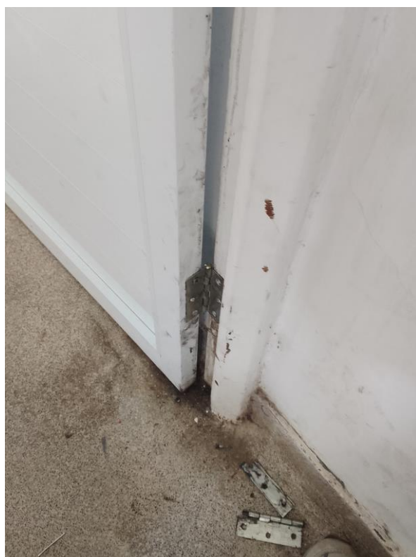
03/11 – substituição dobradiça quebrada entrada recepção pediatria
