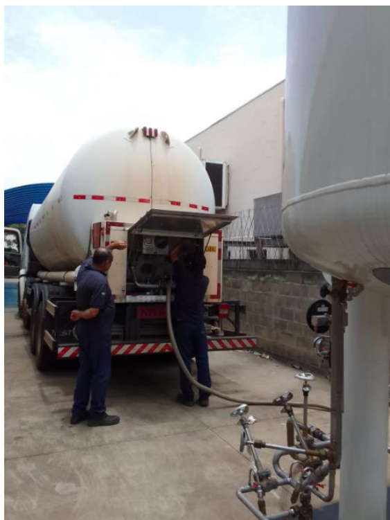
27/11 Abastecimento do tanque de oxigênio
