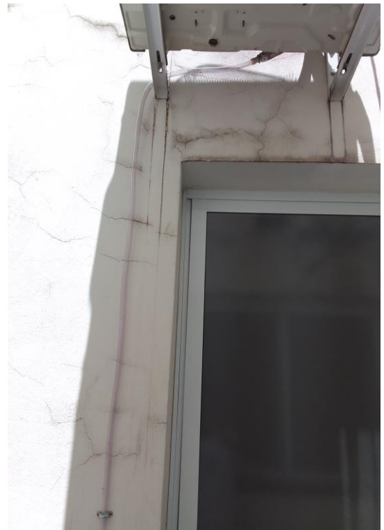
6/11 – instalação mangueira classificação de risco 3
